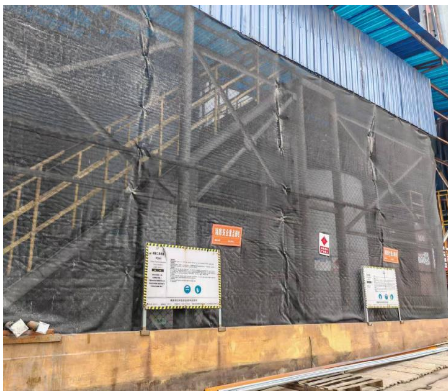
P204 储罐、溶剂油储罐
